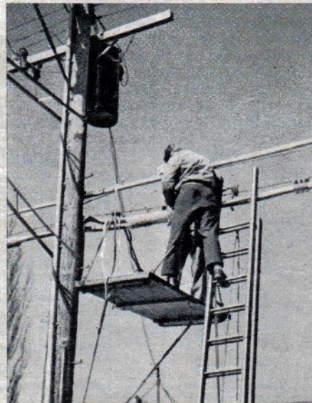
Vermuffen eines hochparigen Luftkabels
